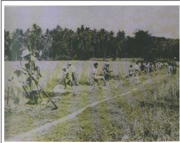
Pembinaan jalan dilaksanakan secara gotong-royong oleh penduduk kampung.
